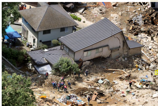
呉市 土砂崩れによる被害
