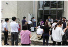
ガス式自家発電機 試運転 (2024/9/30)
